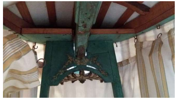
Figura 32 - Detalhe do espaldar
