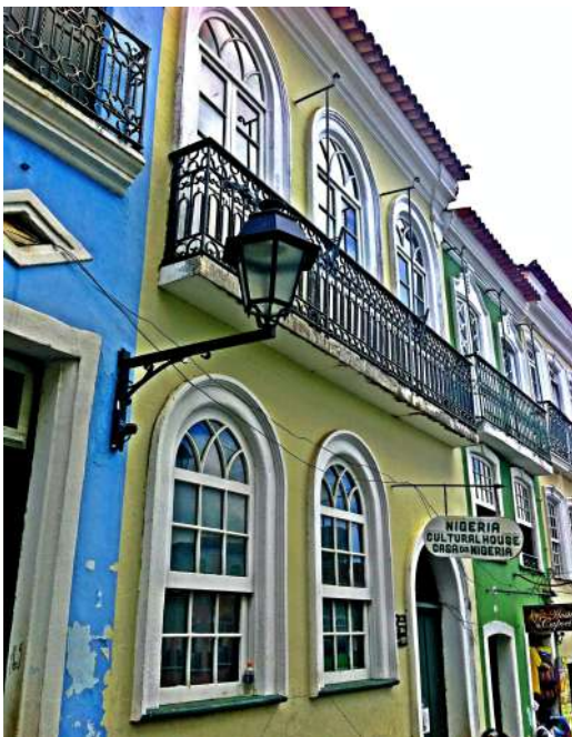
Figura 18 – Vista exterior Casa da Nigéria
