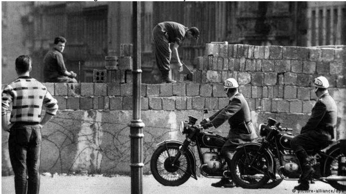
Figura 5 - Início da construção do Muro de Berlim
