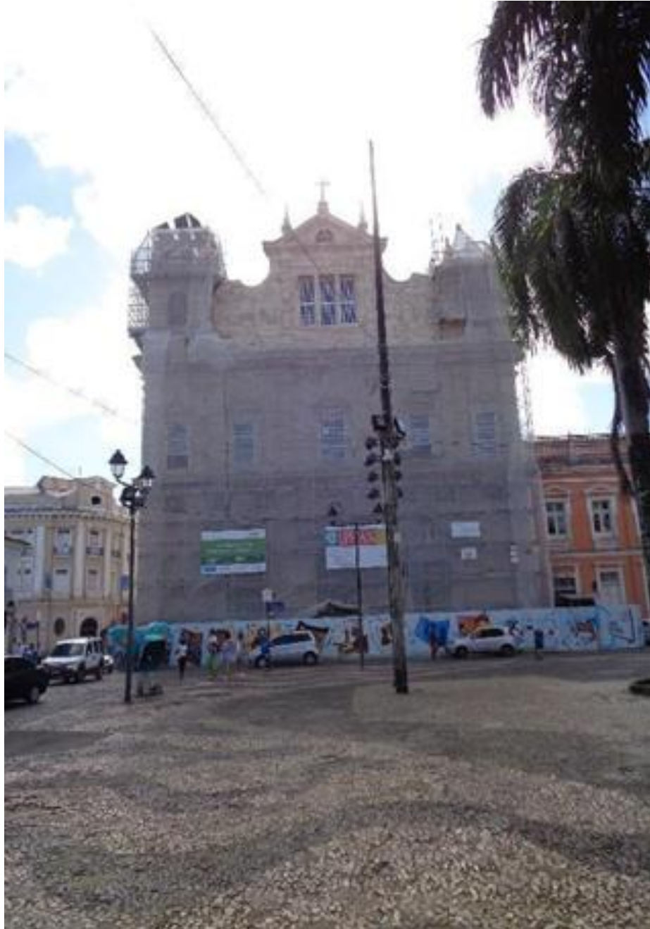
Figura 03 - Vista da Igreja Catedral Basílica de Salvador em restauração
