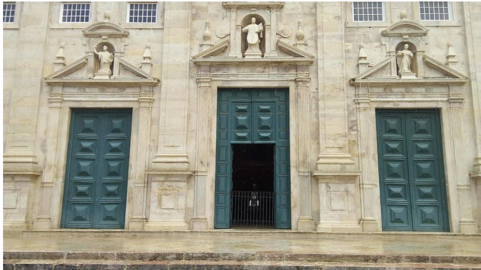
Figura 19 - Detalhe de parte externa da Catedral
