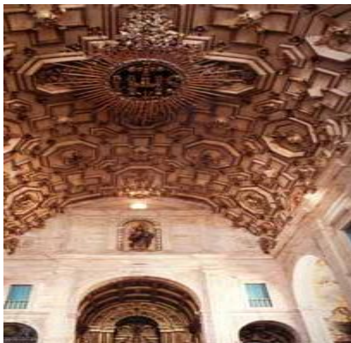
Figura 1- Forro do teto da Catedral Basílica de Salvador, Bahia
