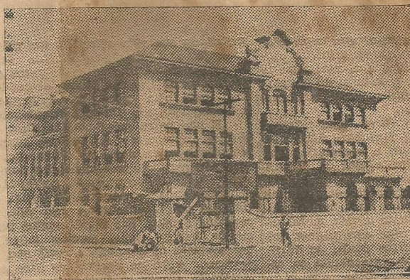
O novo prédio do Instituto Feminino
