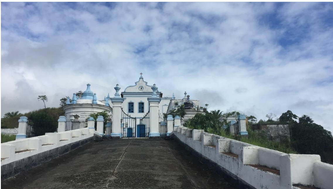
Figura 17 Vista do meio da ladeira, local de acesso à ala mais antiga do Cemitério Nosso Senhor dos Aflitos. Foto: Ritta Maria Mota
